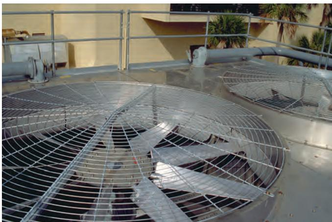
Los ventiladores de alineación de aluminio fundido H3 de Marley se incluyen en diversas líneas de productos de Marley. Todos los conjuntos de ventilador H3 cuentan con cubos de aluminio mecanizados y accesorios de acero inoxidable. Todas las aspas de los ventiladores H3 se adaptan al paso para aprovechar los caballos de fuerza nominales o para compensar las limitaciones inusuales del lugar de trabajo.
