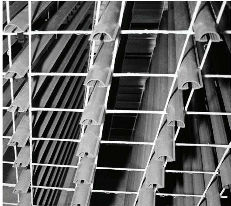
El relleno Alpha III de Marley aumenta la capacidad de rendimiento térmico de la torre de enfriamiento (en comparación con los listones de madera en separaciones similares). La separación variable de la barra del relleno proporciona el rendimiento térmico necesario.
