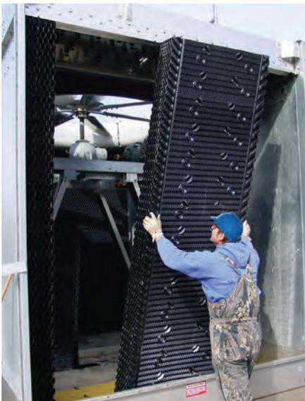
El relleno MBX de Marley es un relleno de conjunto de PVC sostenido desde abajo y de alto rendimiento con persianas integrales y eliminadores de desplazamiento, especialmente diseñado para el mercado de repuestos. Este relleno simplifica y agiliza la instalación y al mismo tiempo ofrece gran eficiencia de enfriamiento sin modificaciones principales a la torre.
